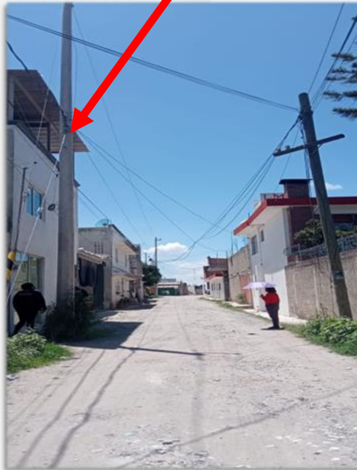
Colocación de luminaria
