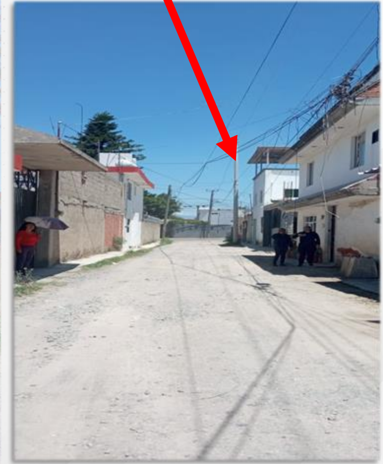
Colocación de luminaria
